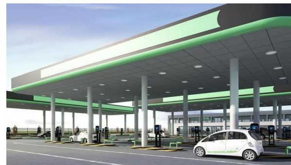
光/储/充一体化超充站
